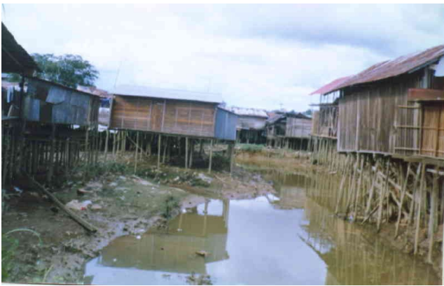
Construcción en las rondas de los ríos.
