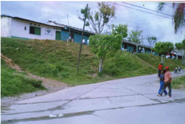
Conflicto de uso entre la escuela y el cementerio
