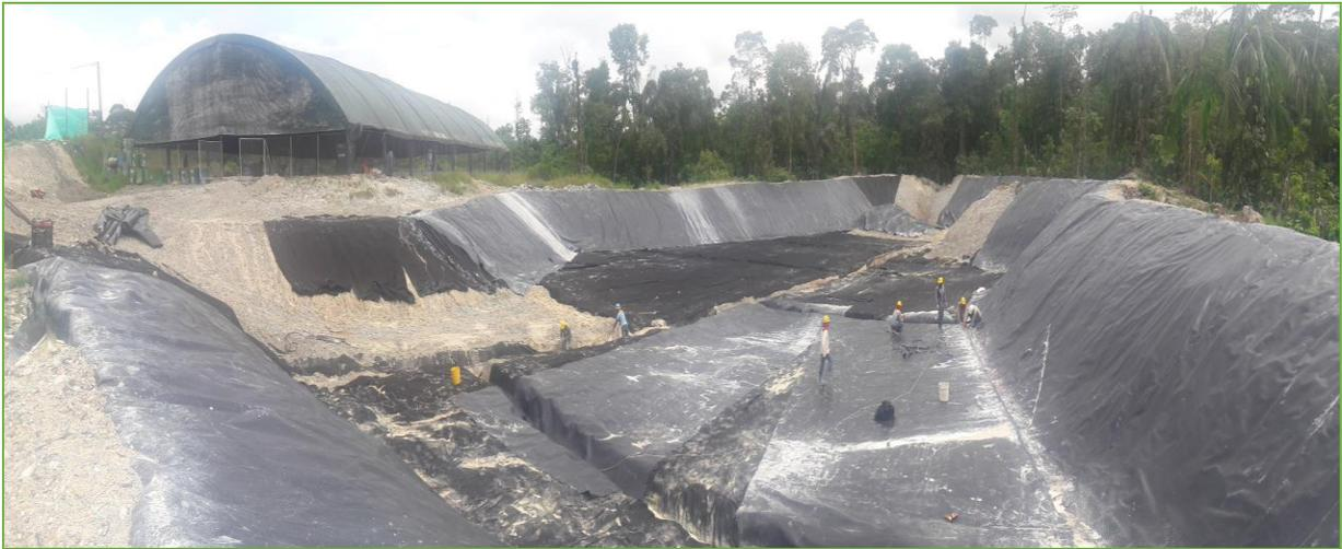
**Figura 12.** Vaso de contingencia en el Sitio de disposición final de residuos sólidos Marmolejo
